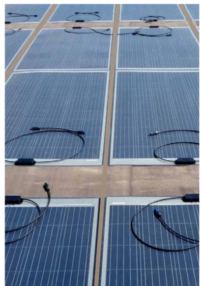
Монтаж модулів DAS Energy на бітум
